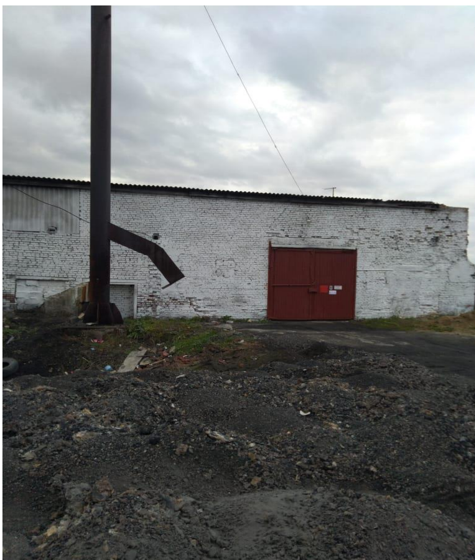
Рисунок. Котельная Мясокамбинат
